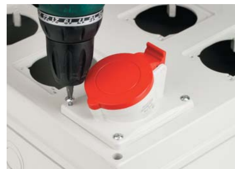
Монтаж розетки на 32 А
